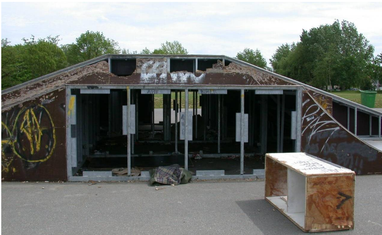
Exemple du skatepark de la base de loisir « Le port aux cerises » dans le 91, après 2 ans d'utilisation. Aucun contrat d'entretien n'avait été prévu. Il est indispensable quand on utilise des matériaux comme le bois.
